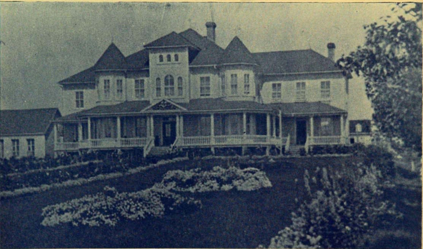
Ancien évêché, presbytère actuel de Havre Saint-Pierre
